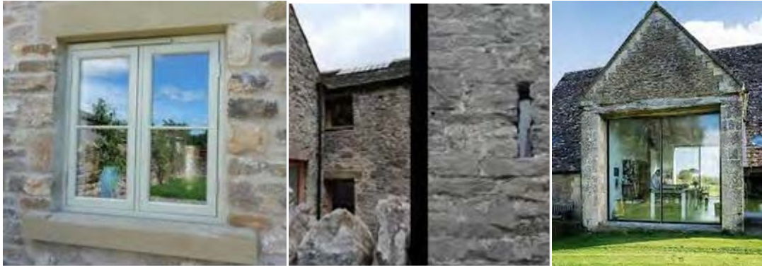
Ffigwr 4: ffenestri pren syml, holltau awyru gwydrog, gwydr uchder llawn mewn agoriadau mawr gyda fframiau tenau.
